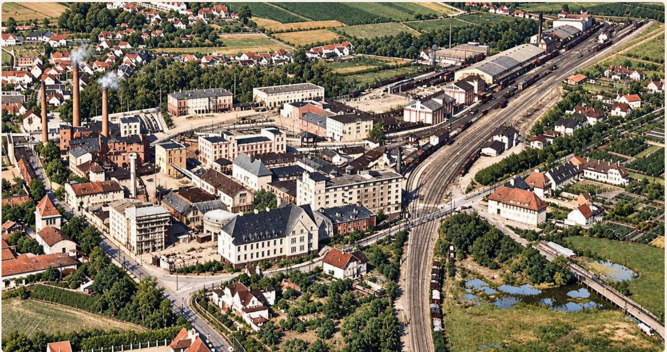
Klein Wanzleben um 1930: Fabrik, Speicher, Verwaltungsgebäude, Bahnhof und Sportplatz liegen beieinander – wie heute (kolorierte Fassung).
